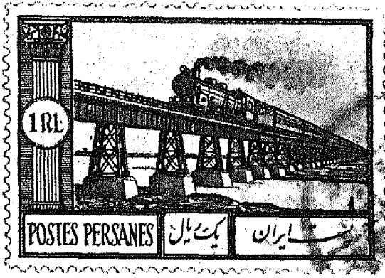
3- 6 جسر حديدي فوق نهر كارون (المسرقان)
